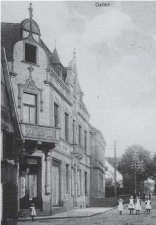
Oststraße 35; heute Bürogebäude
