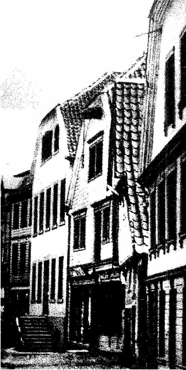
Oststraße 14; heute Wohn- und Geschäftshaus
