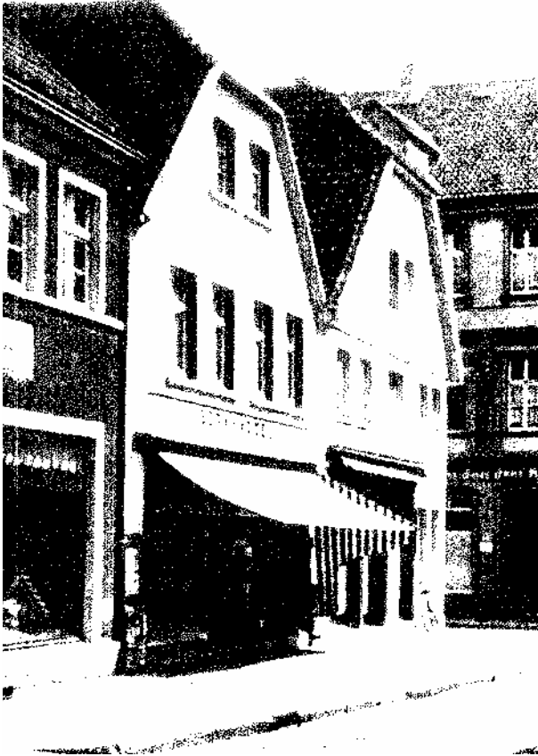
Oststraße 13; heute Wohn- und Geschäftshaus
